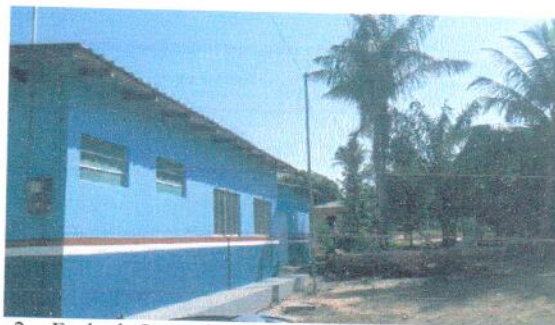
Foto 2 – Fachada Lateral Direita
