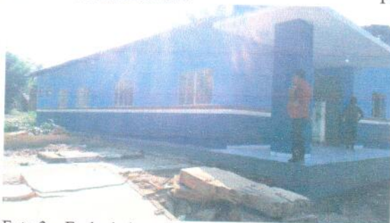
Foto 3 – Fachada lateral Esquerda
